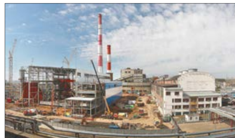
Возведение энергоблока ПГУ-220 МВт на Казанской ТЭЦ-2, 2013 г.
