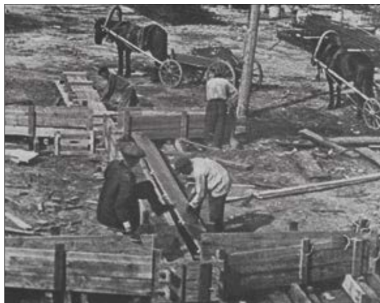
Строительство КТЭЦ-2, 1930-е гг.
